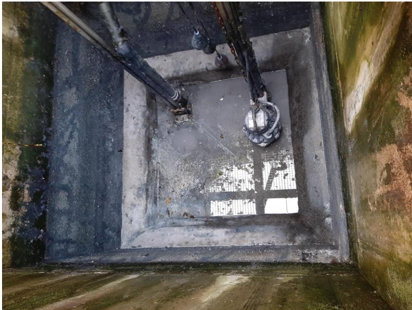
Fosse de relevage après nettoyage
