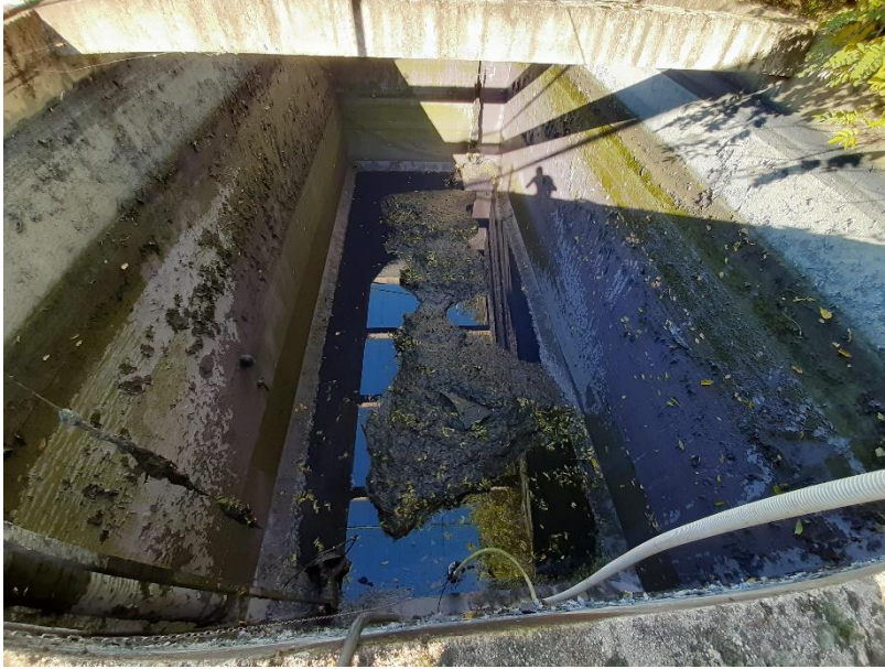
Fin de pompage de la fraction liquide et observation des boues
