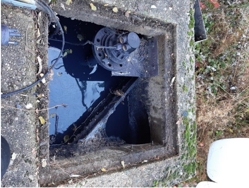
Fosse de sortie avant nettoyage
