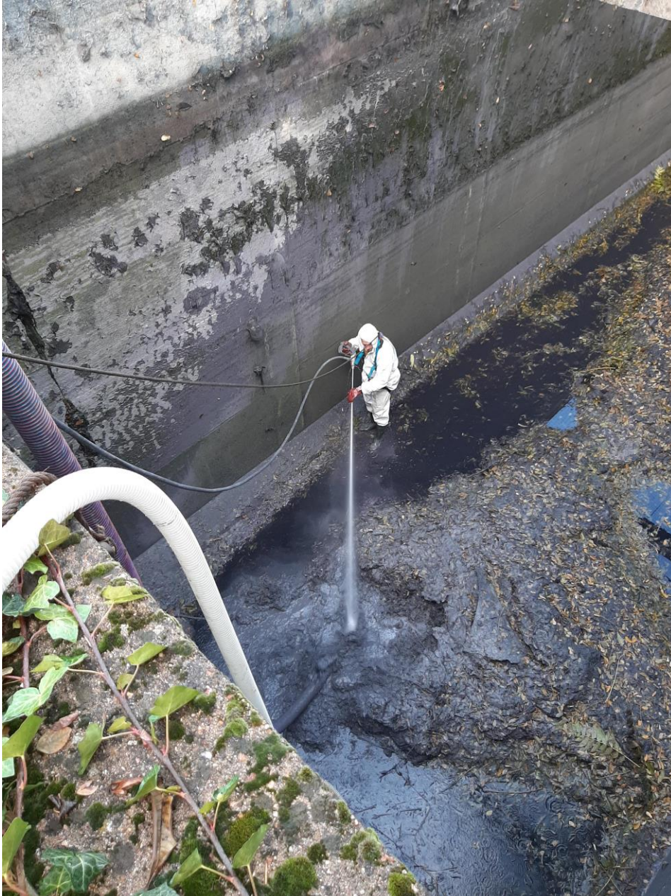
Intervention des hydrocureurs
