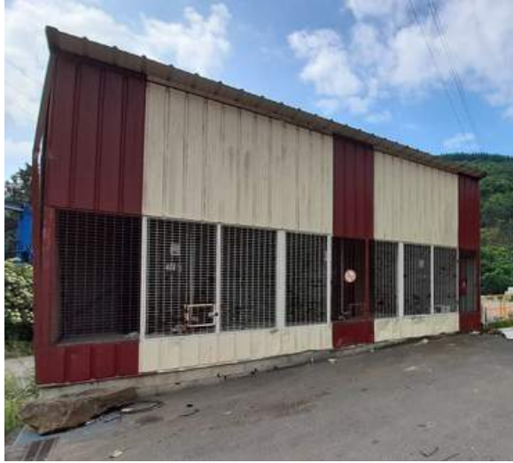
Parc à cuves (contenant trois cuves)
