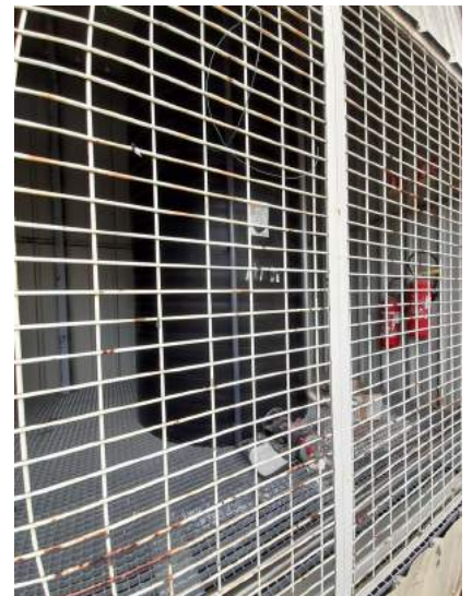
Cuve de lessive de soude
