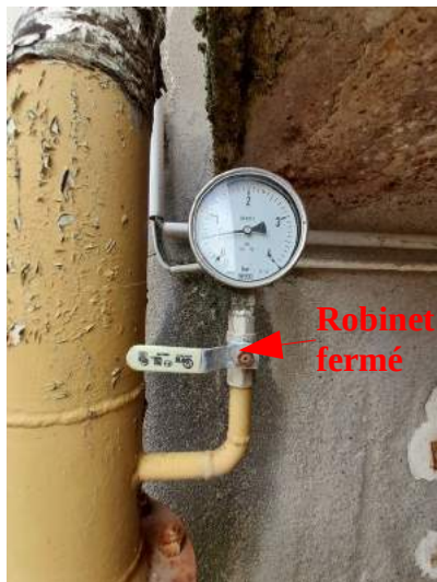
Manomètres du réseau de gaz dans le local chaufferie
