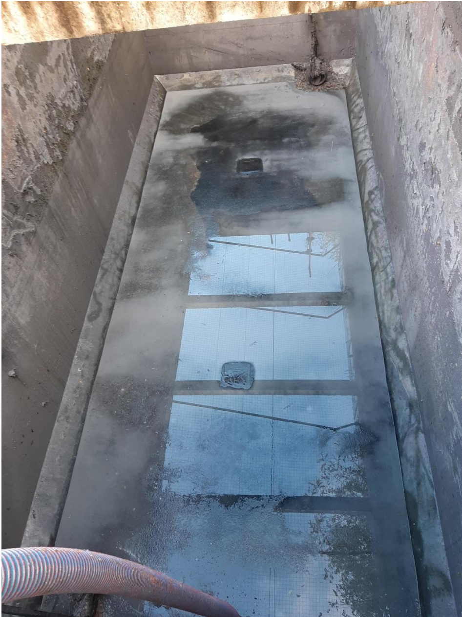
Bassin après nettoyage
