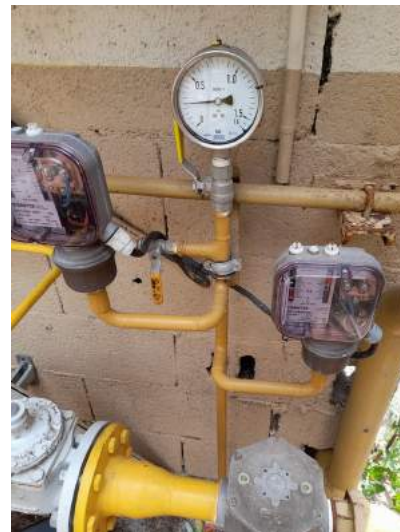
Manomètres du réseau de gaz dans le local chaufferie
