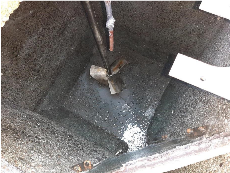
Fosse de sortie après nettoyage
